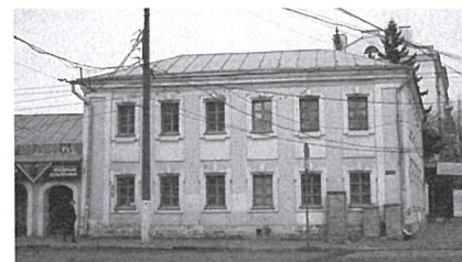
Гостиница Андриевской (дом Елизаветы Петровны Каменевой) на перекрестке Ильинского переулкa и улицы Новоторжской
